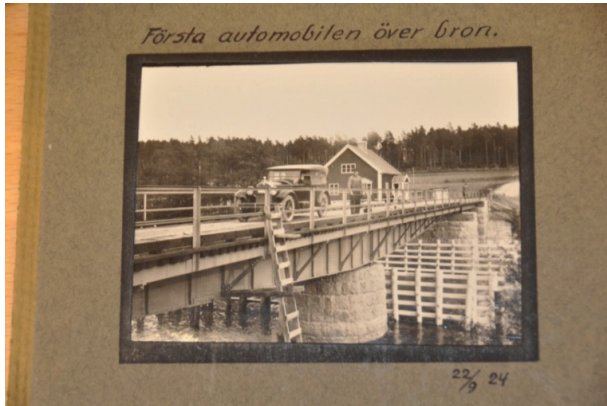
1924 invigdes Flottsundsbron efter omfattande renovering. Bilden är tagen av entreprenören Anders Strandberg. (ur Uppsala och Upplandsamlingen, Uppsala stadsbibliotek, EP).
